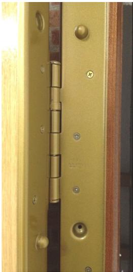
Conjunto acorazado de 5 puntos de entrada. Cerradura central de 3 bulones planos de 20x14 mm en acero y 4 cajas auxiliares con 3 bulones en acero de 15 mm accionados desde cerradura central.
