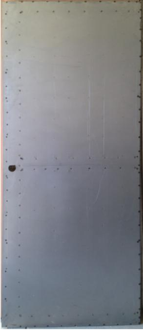
Bastidor fabricado en tubo de acero soldado a una chapa de acero en su parte exterior y reforzado con omegas soldadas por su parte interior
